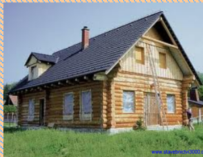
Obr. 58 Vazba rohu úplným rybinovitým přepletováním www.drevostavby-rychle.cz
